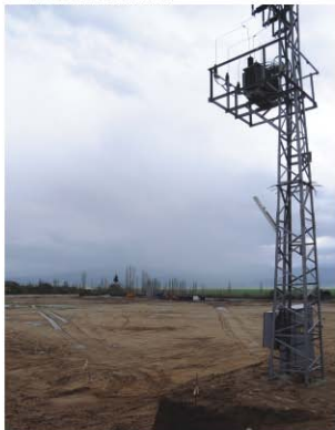
İnşaatı devam eden Dora 2 jeotermal elektrik santrali
