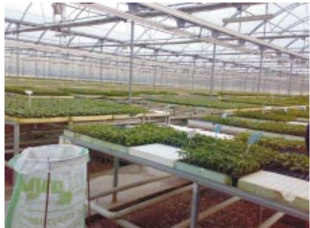
Resim 4. Jeotermal enerjiyle ısıtılan sera
